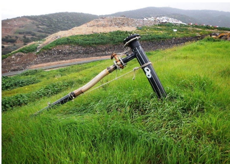
Pozzo di captazione del biogas
