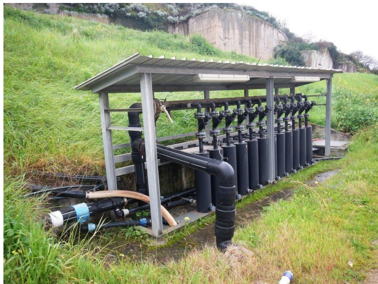
Stazione di regolazione del biogas
